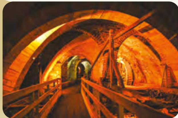
— Le mécanisme hydraulique du puits d'Amont
