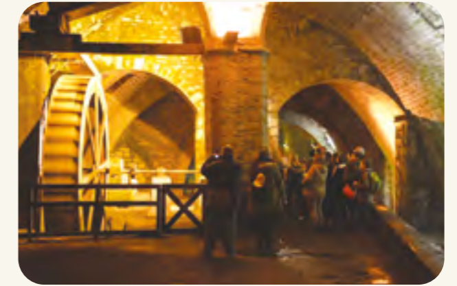
— La galerie souterraine abrite une pompe hydraulique en fonctionnement
